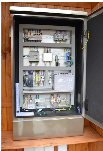
Slika 5: Avtomatska merilna postaja za površinske vode s priklopom na javno elektro omrežje, tip komunikacije ADSL/MPLS
